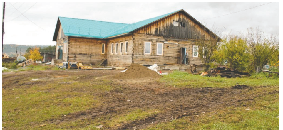
Ход капитального ремонта Кижинского детского сада
